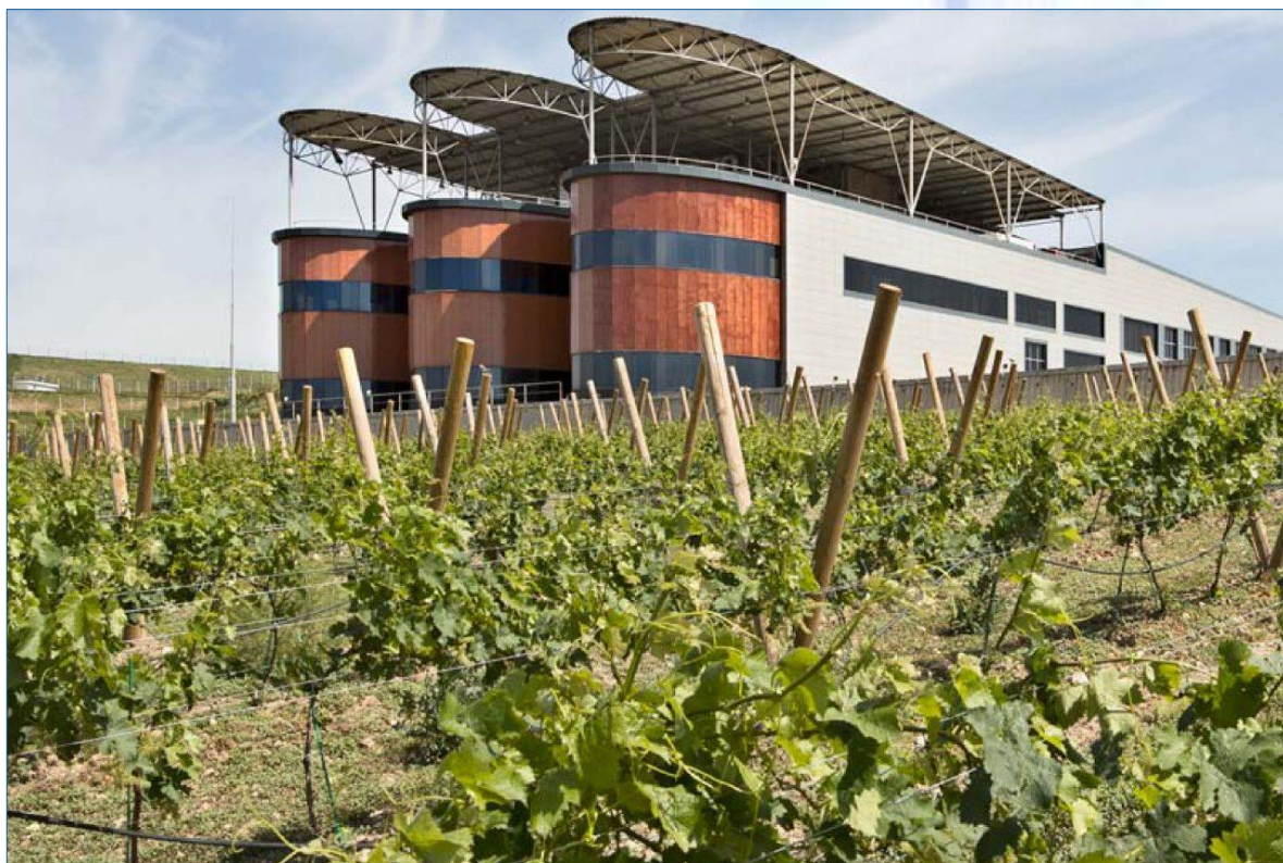
Производственные цеха похожи одновременно на корабль, выплывающий из крымского холма, и на череду бочек, глубоко погруженные в винные подвалы. Фото размещено в свободном доступе на платформе: https://clck.ru/3CUAMA
